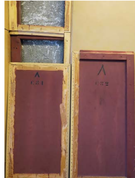
Avant le début des travaux de rénovation, trois panneaux ont été retirés afin d'étudier leur construction et leur montage. Chaque panneau est numéroté au dos.
