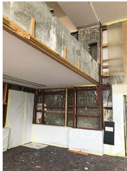
Une fois les panneaux en cuir retirés, les panneaux en bois situés juste en dessous ont été recouverts de feuilles de protection blanches.
