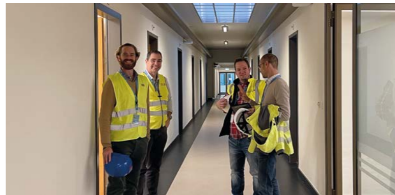
© RÉNOVATION PALAIS DES NATIONS SA/LORENZO BARNINI
