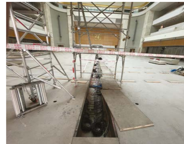
© RÉNOVATION PALAIS DES NATIONS SA/LORENZO BARNINI
