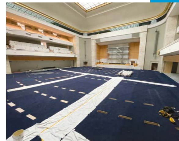
© RÉNOVATION PALAIS DES NATIONS SA/LORENZO BARNINI
