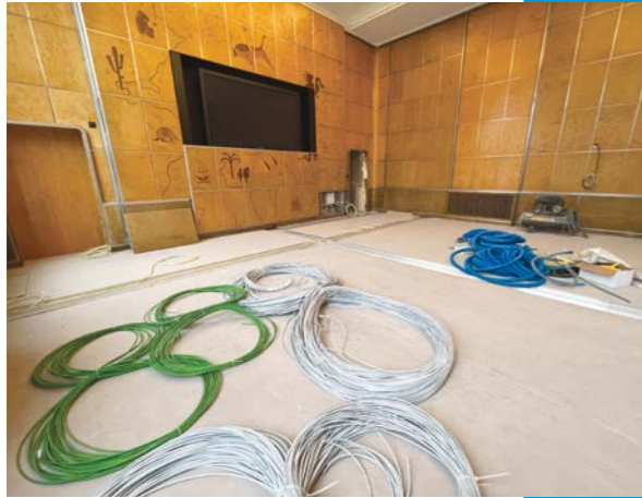
© RÉNOVATION PALAIS DES NATIONS SA/LORENZO BARNINI
