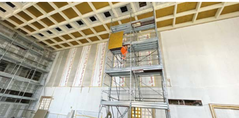
© RÉNOVATION PALAIS DES NATIONS SA/LORENZO BARNINI
