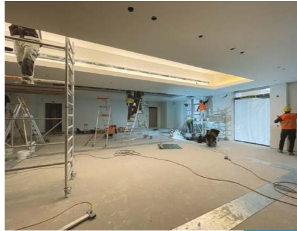
© RÉNOVATION PALAIS DES NATIONS SA/LORENZO BARNINI
