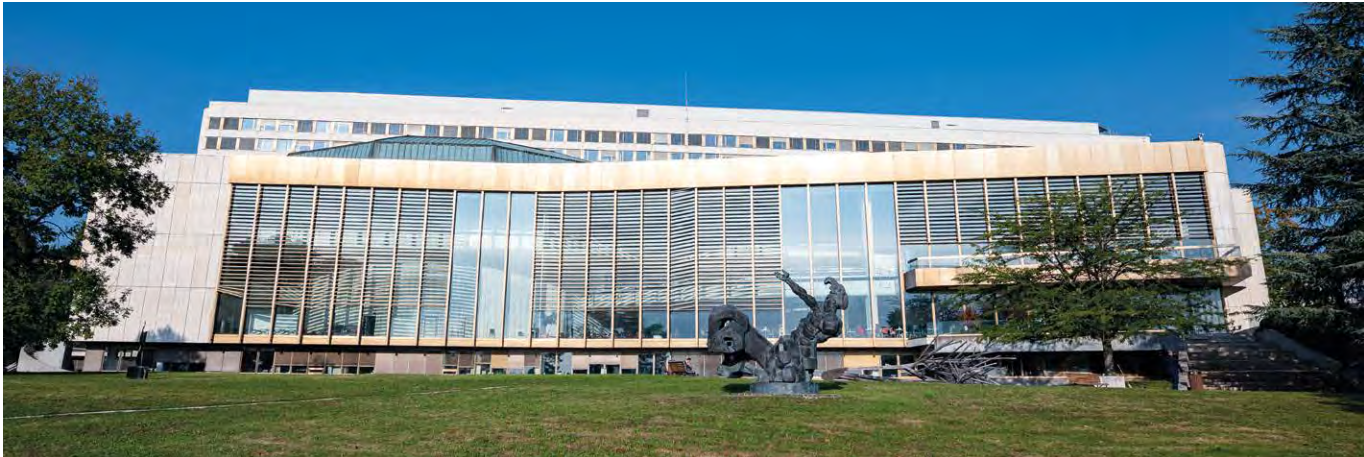
La façade côté lac du bâtiment E date du début des années 1970 et comprend 24 grandes fenêtres à double vitrage. ©Photo ONU : Matija Potocnik
