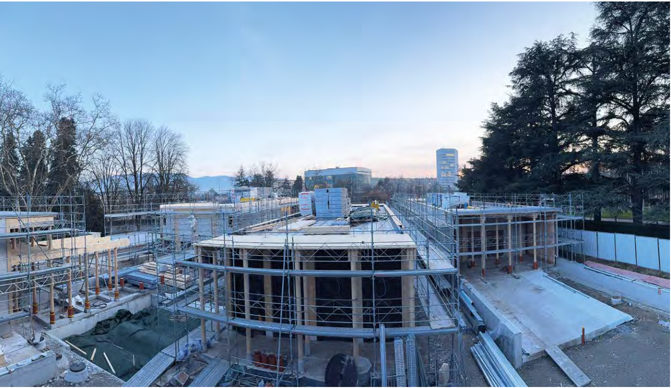
Le Centre des visiteurs du Portail des Nations, en cours de construction, devrait ouvrir ses portes en 2026. ©Photo ONU: Charbel Jabbour
