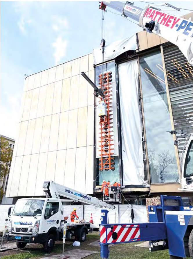
Dans le cadre des travaux préparatoires, deux des fenêtres à double vitrage existantes sont enlevées par un entrepreneur. ©Photo ONU : Plan stratégique patrimonial
