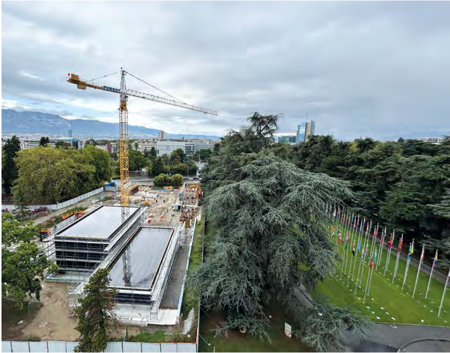
Le Centre des visiteurs du Portail des Nations, dont les travaux progressent, devrait ouvrir ses portes en 2026. ©Photo ONU : François Vioud
