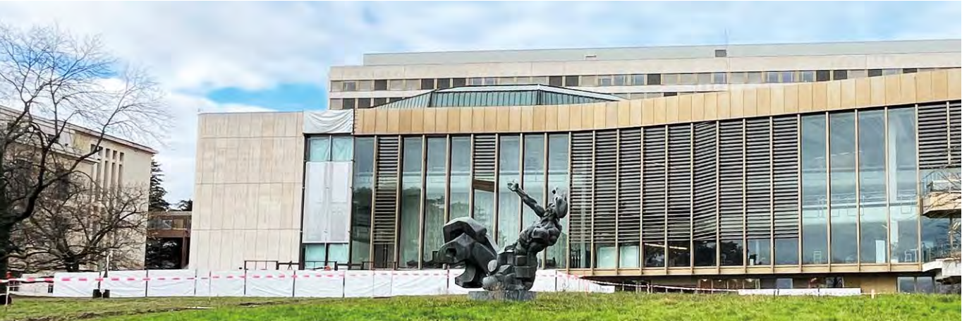
Un prototype des nouvelles fenêtre est installé. Des spécialistes du bâtiment et du patrimoine l'examineront avant de lancer la fabrication de l'ensemble des fenêtres qui composeront la façade rénovée. ©Photo ONU : Plan stratégique patrimonial
