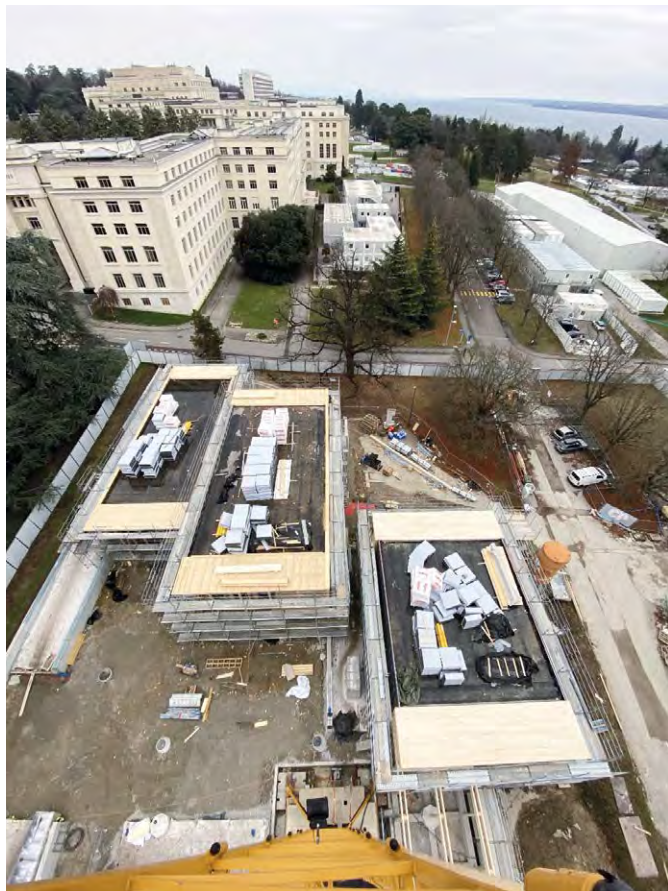
Le chantier du nouveau Centre des visiteurs du Portail des Nations, vu depuis une grue. ©Photo: Charles Pictet Baptiste Broillet Architectes Associés
